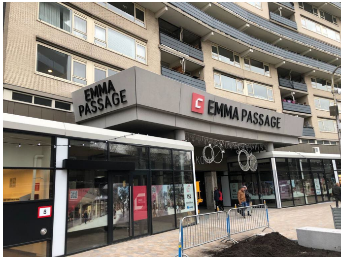
Nieuwe ingang, in samenwerking met MN (eigenaar)
