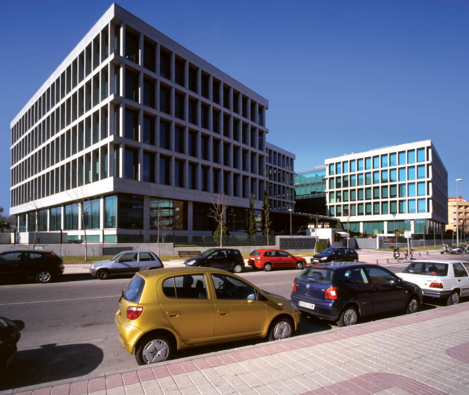
15 Avenida de la Vega, Alcobendas, Madrid
